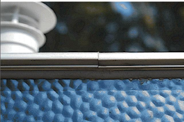
Bevor Sie die Zelthaut in die Kederschiene einziehen, sollten Sie zuerst die Stoßfuge der Kederschiene, soweit vorhanden, von oben abdichten. Scharfkantige Kedereinführungen sollten unbedingt entgratet werden.
