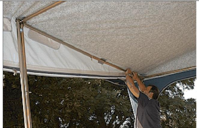
Dann den Mittelwinkel D und den Eckwinkel F mit einer Giebelstange verbinden.
