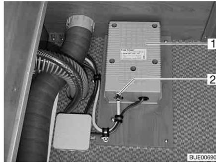
Bild 129 Trafo für elektrische Fußbodenheizung
